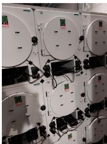
Afbeelding 16. Modulaire beschermkasten voor de accu van OV-fiets e-bikes op station Driebergen-Zeist.
